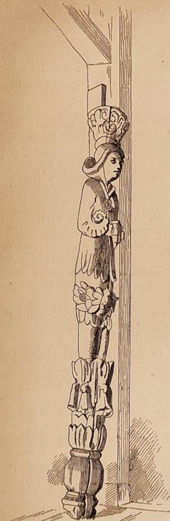
Ehemaliger Emporenpfeiler auf dem Dachboden der Kirche zu Caselwitz.
